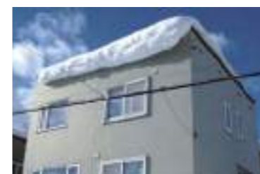
北海道の冬に雪が降り続ける限り心配のタネ、知らず知らずのうちに危険が迫っている雪庇。
