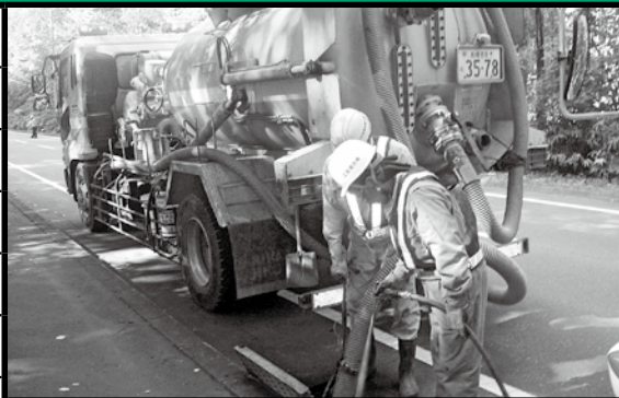
高圧洗浄機による市道維持業務(雨水桝清掃)
