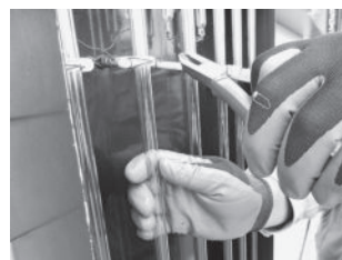
ネオンサイン設置作業
