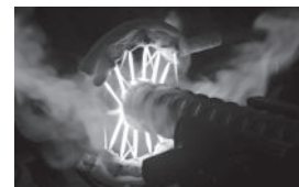
ガスで鉄筋を加熱します
