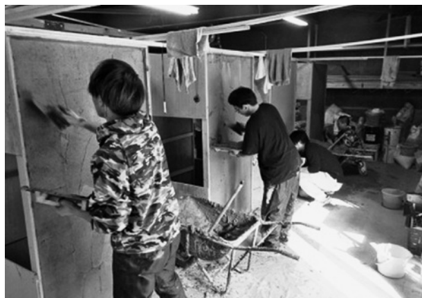
塗り壁トレーニングの様子
