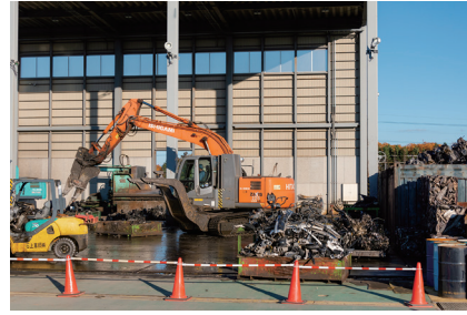
解体作業工程で、抜き取ったハーネスがナゲット処理設備の前に落とし込まれるようにラインを組んでいる
