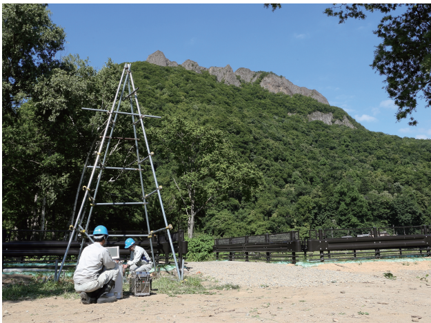
八剣山テストフィールドに模擬孔をつくり実証試験を行った
