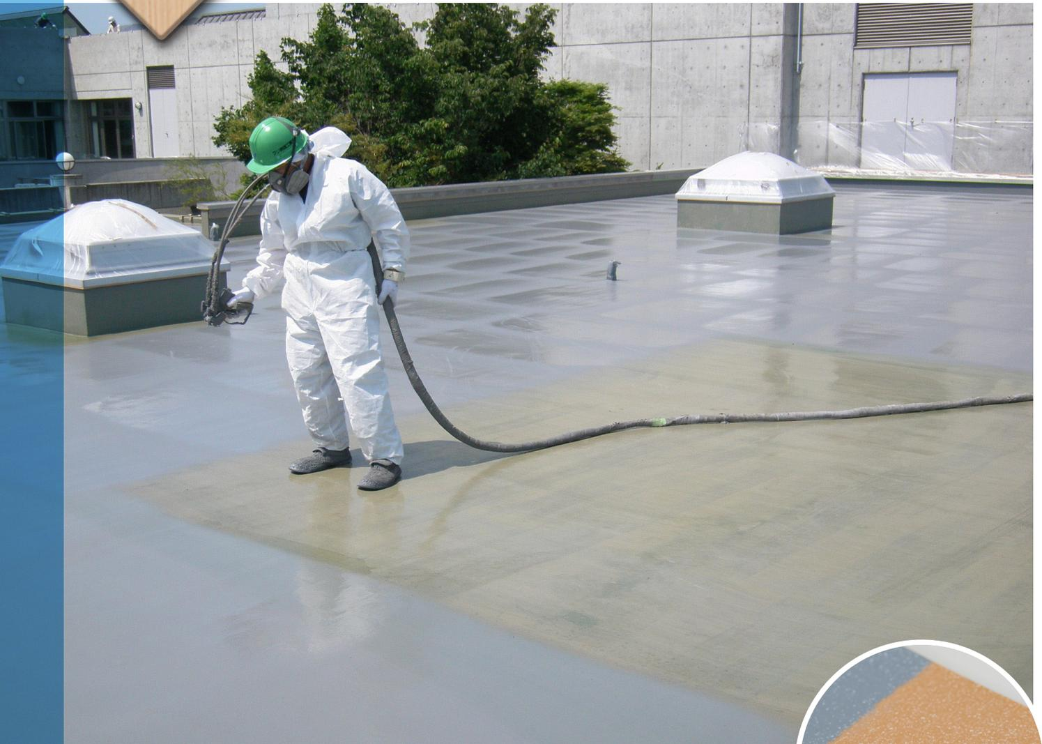
超速硬化ウレタン吹付工法の最大の特長は、極めて短い時間で“指触乾燥・硬化”すること。施工部位の短期間での仕上げを可能とするだけでなく、勾配・傾斜部や複雑な形状においても膜厚が確保できる
