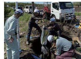
消火栓取替工事
