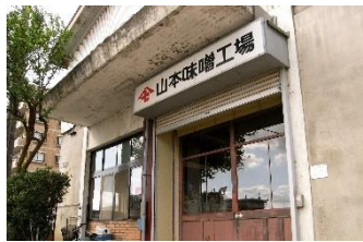
味噌を醸造する工場の外観
