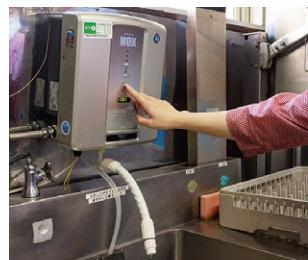
電解水生成装置は、水と塩から酸性の次亜塙素水とアルカリ性の洗浄水を作れる。化学薬品を使わないため人体や食材、環境への害がない。消毒薬による殺菌では、菌に耐性ができる薬剤がなくなったり、手が荒れたりするが、この水は菌の生存環境そのものを破壊するため、効果が持続する。調理スタッフの手洗いやまな板などの調理器具の消毒、キッチンの清掃などに活用されている。
